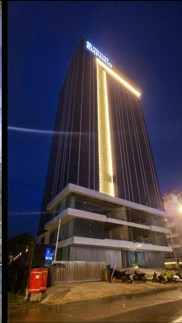
ACTUAL SITE PHOTO
