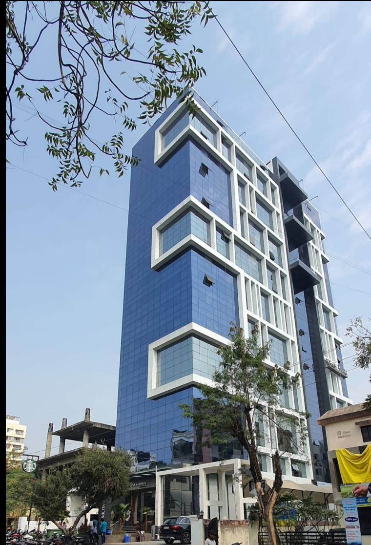
ACTUAL SITE PHOTO
