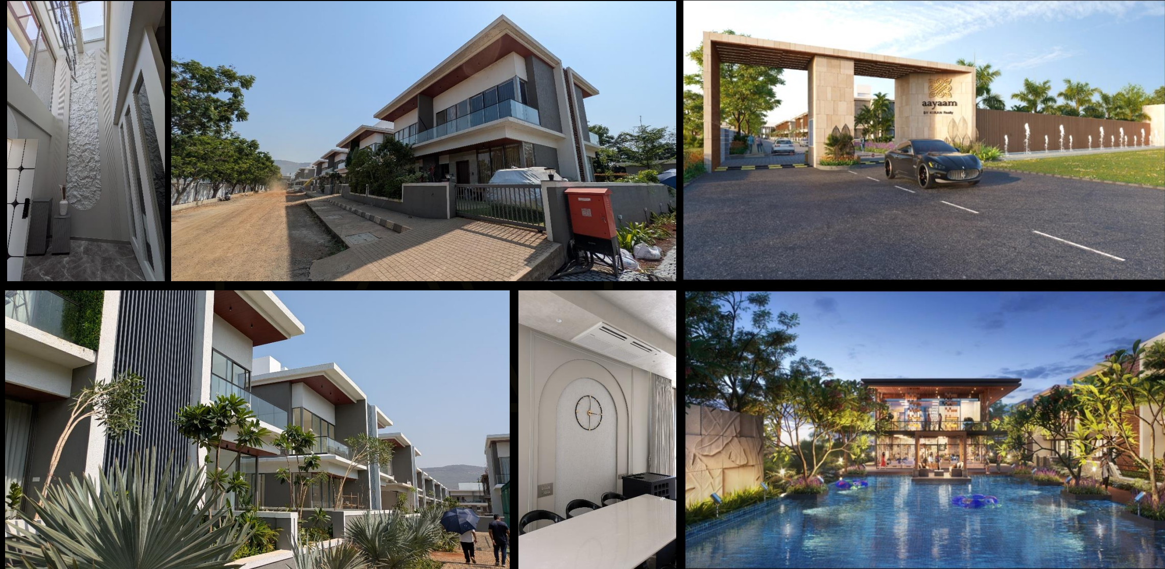
ACTUAL SITE PHOTO
