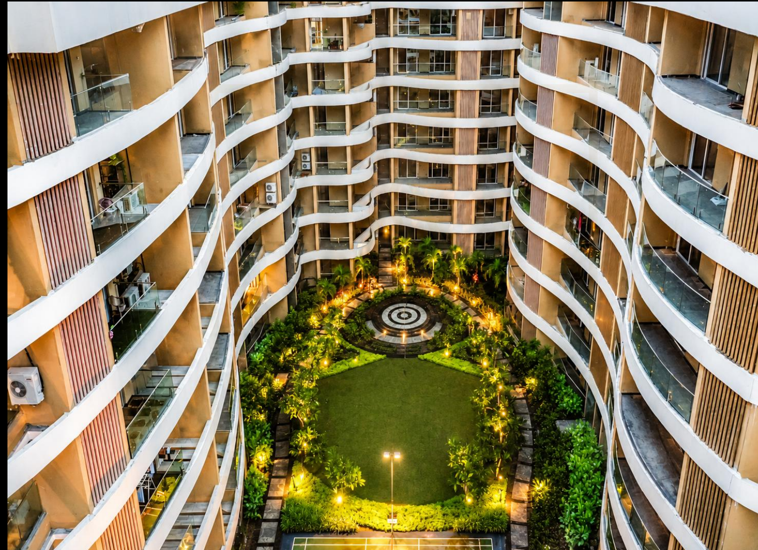
ACTUAL SITE PHOTOS
