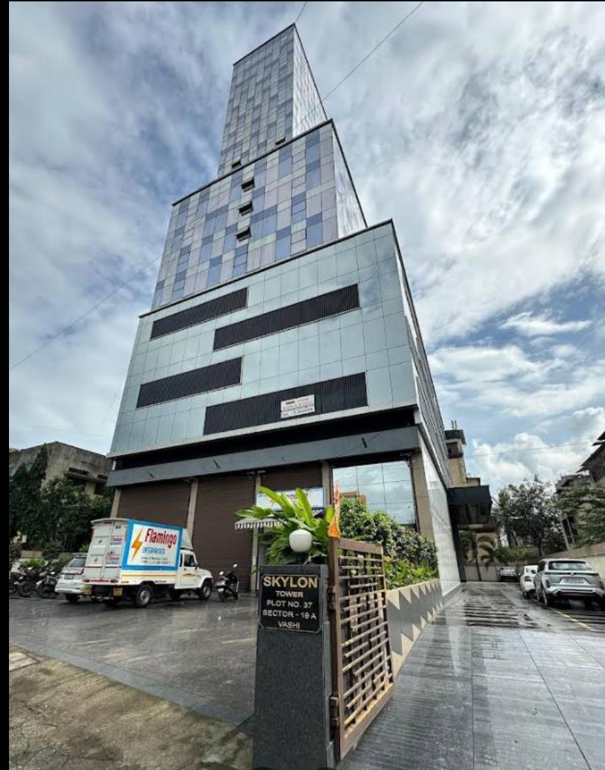
ACTUAL SITE PHOTO
