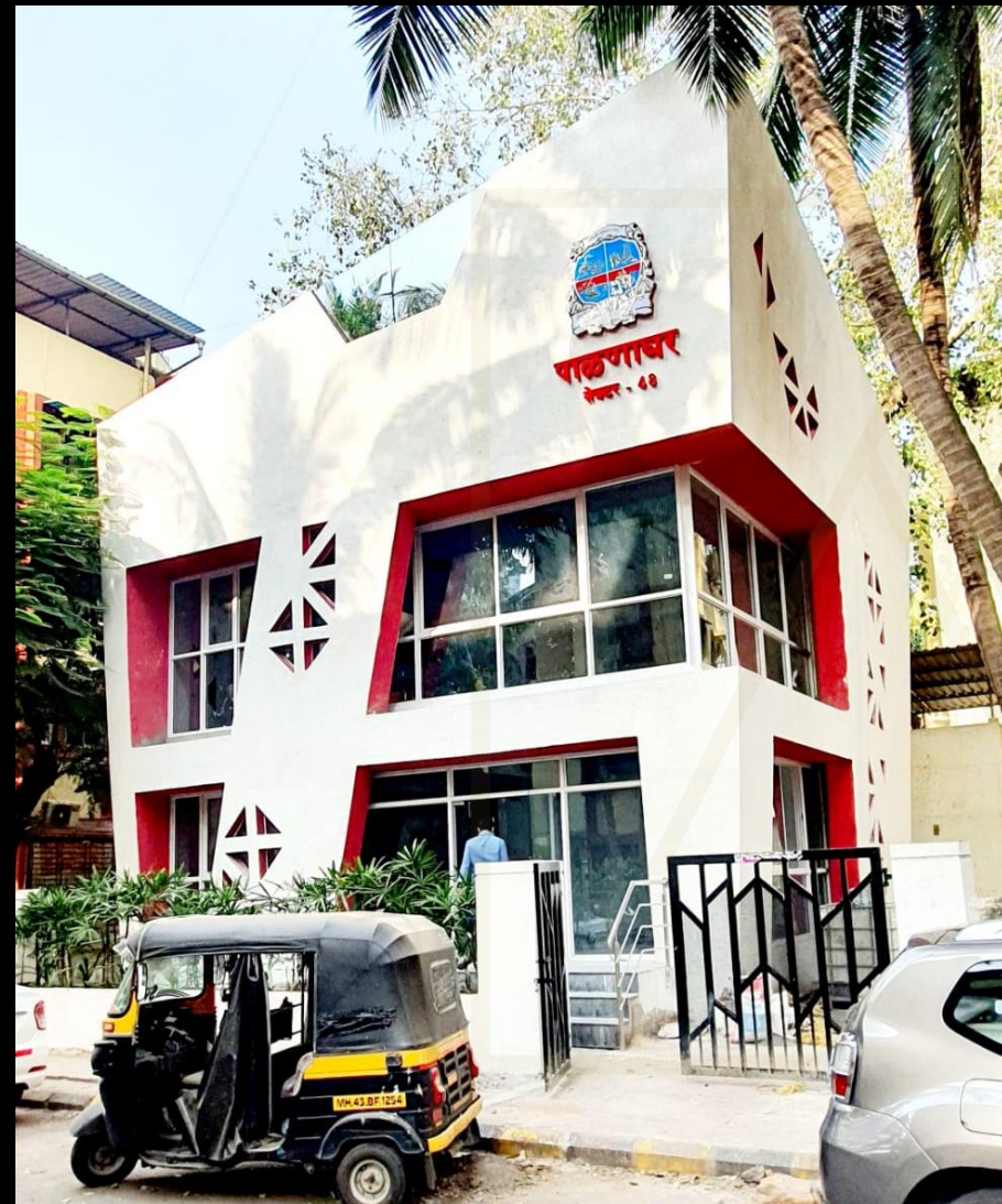
ACTUAL SITE PHOTO
