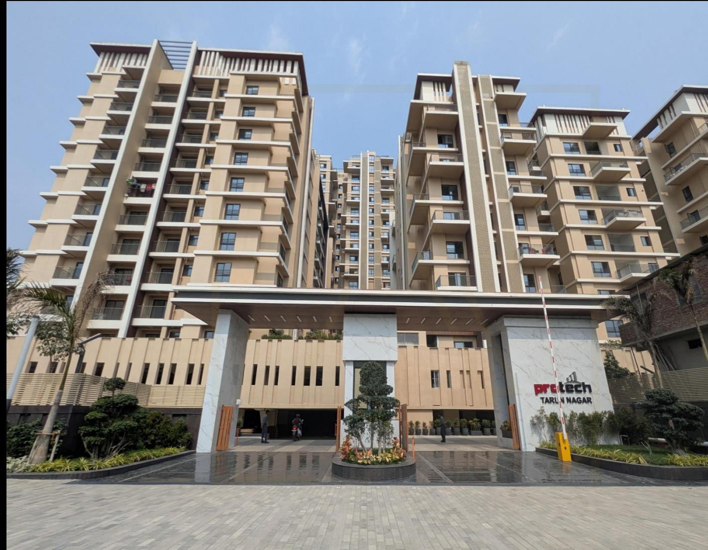
ACTUAL SITE PHOTOS
